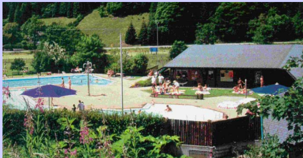
Sanierung des Freibades
